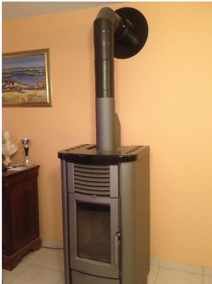
*Installation d'un poêle hybride de marque Paterno. Ce poêle fonctionne en granulés et en bûches de 33cm. Possibilité de programmer le démarrage en granulé et de passer en bûches à notre arrivée.*
