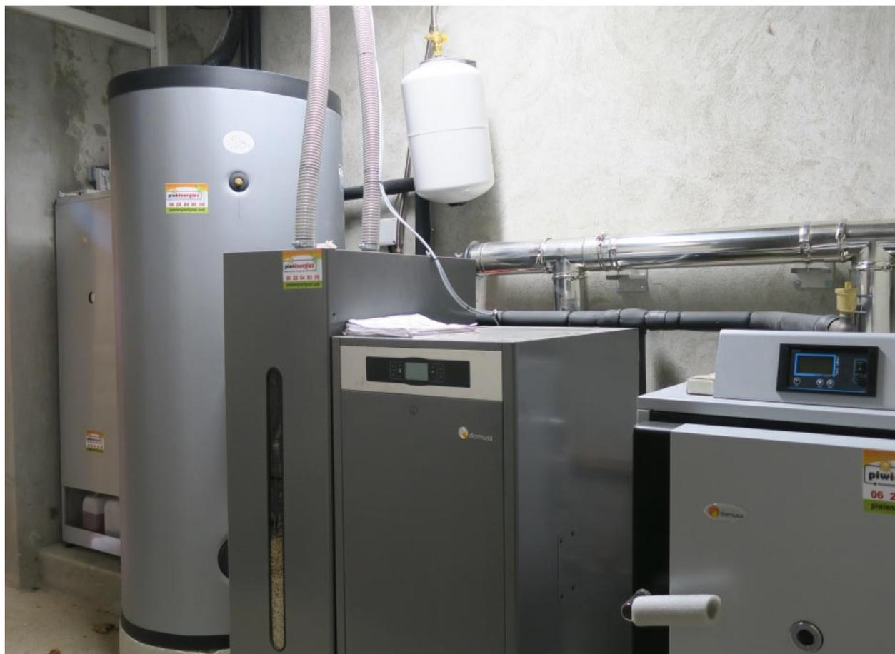
*En Savoie à 10 Kms de Chambéry, installation d'un chauffage solaire de marque Solisart SC2 équipé d'un ballon sanitaire de 600 litres, d'un ballon tampon de 1000 litres et de 6 capteurs en intégration toiture. L'appoint se fait soit par une chaudière granulés Domusa de 15Kw soit par une chaudière bois buche de 30Kw. Cet ensemble a été mis en remplacement d'un système de chauffage géothermique Sofath.*
