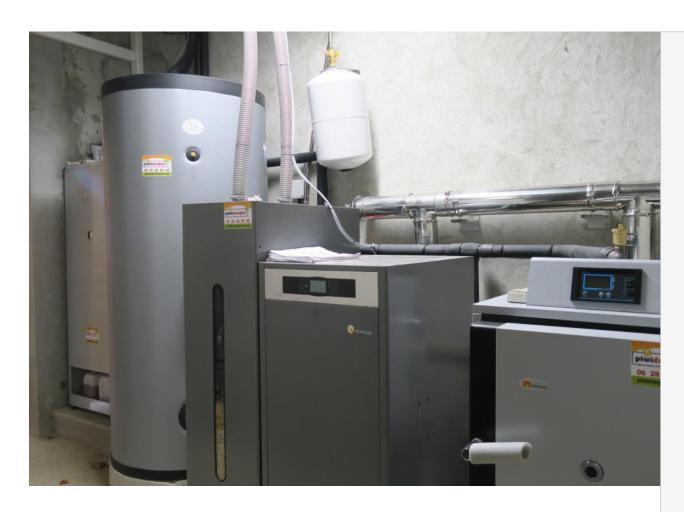
En Savoie à 10 Kms de Chambéry, installation de deux chaudières de marque DOMUSA, une Bûches de 30Kw avec son ballon tampon de 1000litres et une à granulés de 15Kw le tout en appoint d'un chauffage solaire Solisart.
