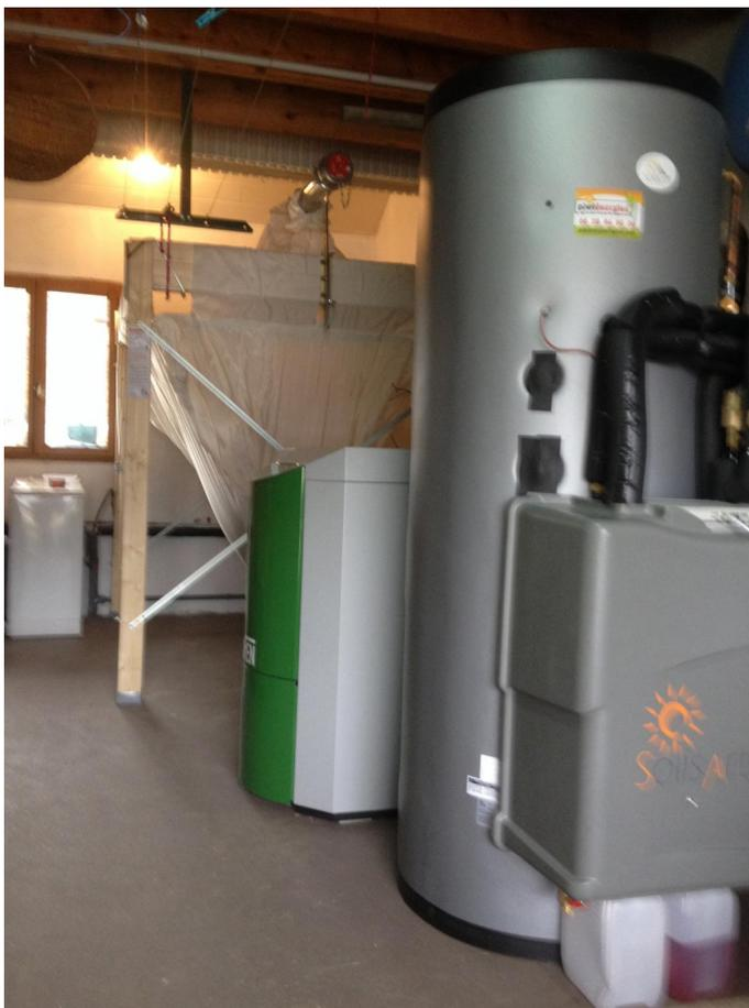
*A 20Kms de Chambéry en Savoie, installation d'un Chauffage Solaire Combiné de marque Solisart SC1 équipé d'un ballon sanitaire de 500 litres et de 6 capteurs montés sur châssis au sol. L'appoint se fait par une Chaudière à granules Okofen de 15Kw.*
